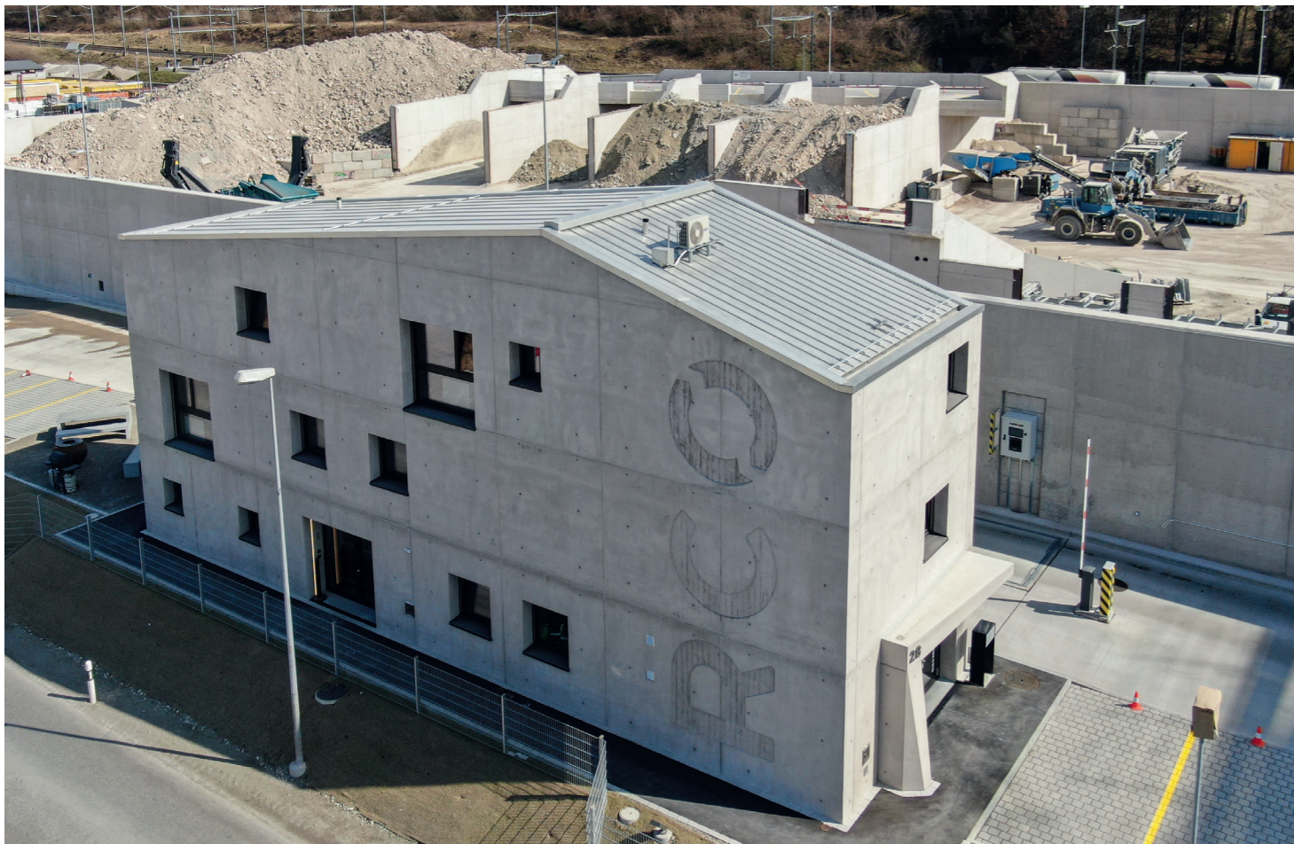
Neue Recycling-Aufbereitungsanlage: Architektur, Technologie und Nachhaltigkeit in einem.
