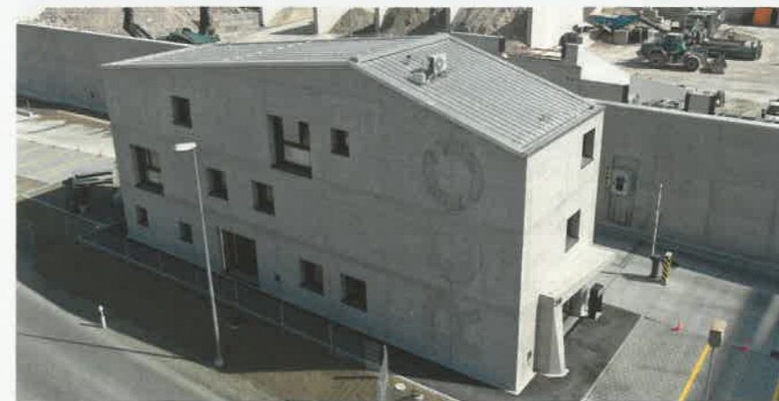
Bild 3: Das Firmengebäude des Recyclingcenters besteht größtenteils aus rezykliertem Baumaterial.
